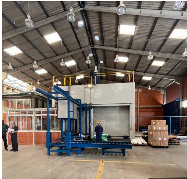
Chegada das obras no IPEN/USP para tratamento em câmara de radiação. Data: 13 de dezembro de 2024. Foto: Angela Fileno.
